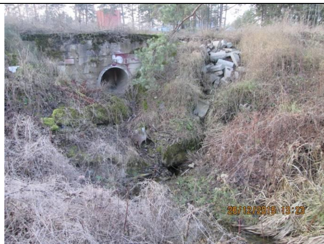
Attēls Nr.120 Caurteka, kas šķērso dzelzceļu Uzvaras ielas pusē
