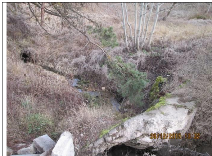
Attēls Nr.119 Caurteka, kas šķērso dzelzceļu Uzvaras ielas pusē
