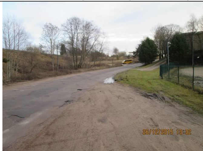
Attēls Nr.121 Uzvaras iela pie caurtekas no dzelzceļa
