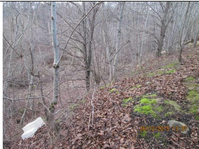
Attēls Nr.122 Iespējamā lietus ūdeņu ieplūde no dzelzceļa caurtekas esošajā gravā
