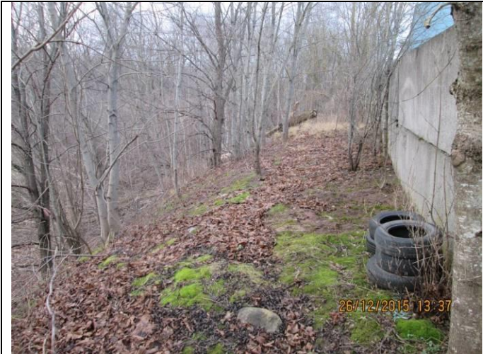
Attēls Nr.123 Iespējamā lietus ūdeņu ieplūde no dzelzceļa caurtekas esošajā gravā
