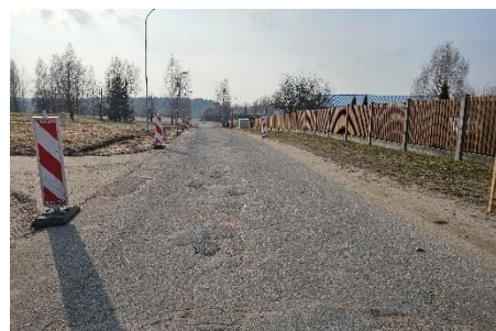
11. attēls. Odukalna ielas pārbūve.
