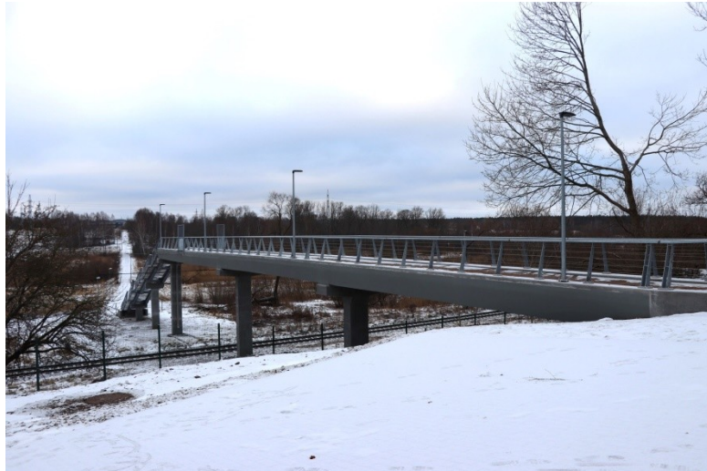
1.19.attēls. Gājēju pārvads pār dzelzceļu Tukumā
