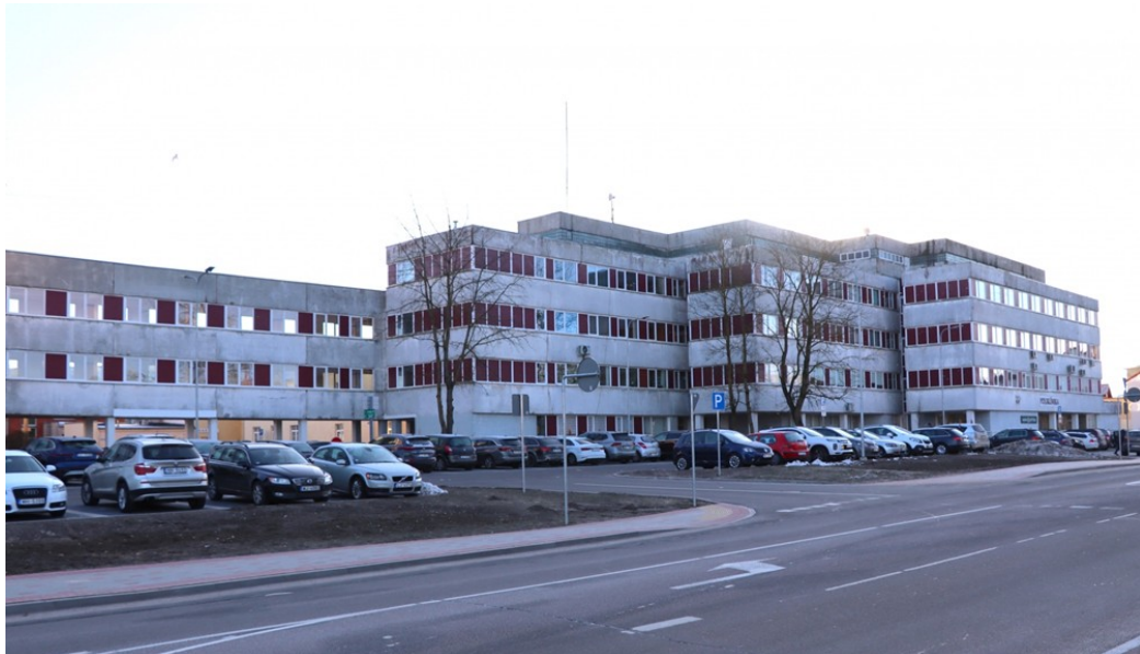
1.20.attēls. Tukuma slimnīcas stāvlaukums
