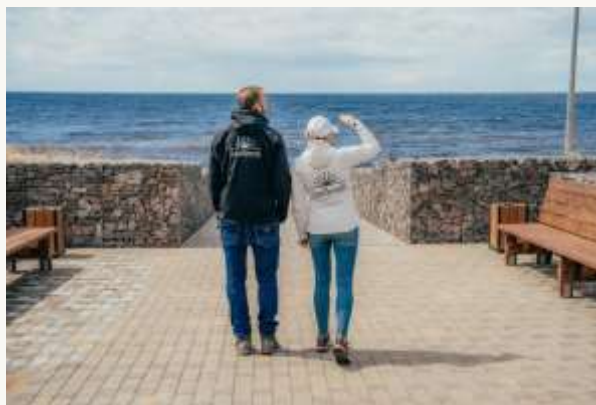
13. attēls. Projektā "Infrastrukturā izbūve Jūras parkā, Saulkrastos" izbūvētā gabionu siena
