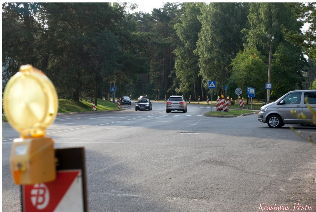
Rīgas ielas pārbūve
