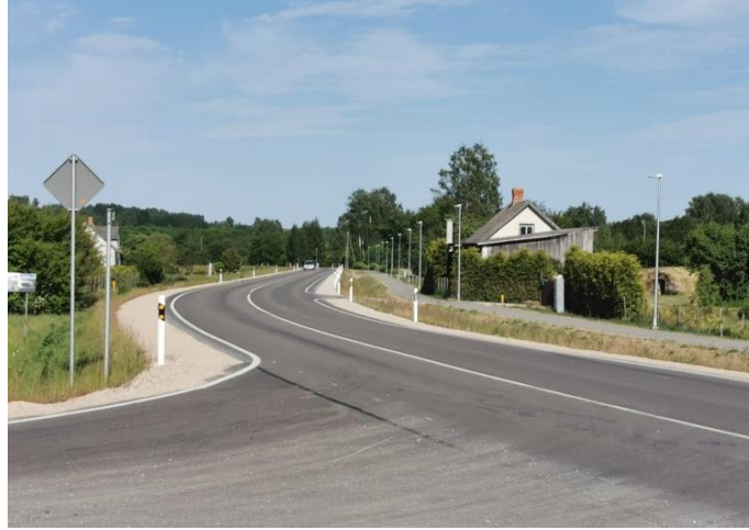
3.19.attēls. Sātos izbūvēts gājēju celiņš ar apgaismojumu.
