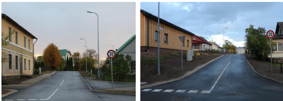
39.-40. attēli. Veikta Siguldas un Pumpura ielu pārbūve
