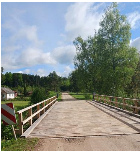
48. attēls. Veikts Aptiekas tilta koka virsmas un margu remonts
