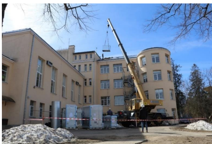
26. attēls. Projekta īstenošanas gaitā lielākās ventilācijas sistēmas detaļas tika ieceltas pa atveri ēkas jumtā
