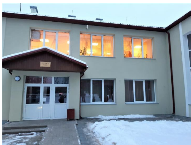
38. attēls. Annas kultūras nama ēkas energoefektivitātes paaugstināšana
