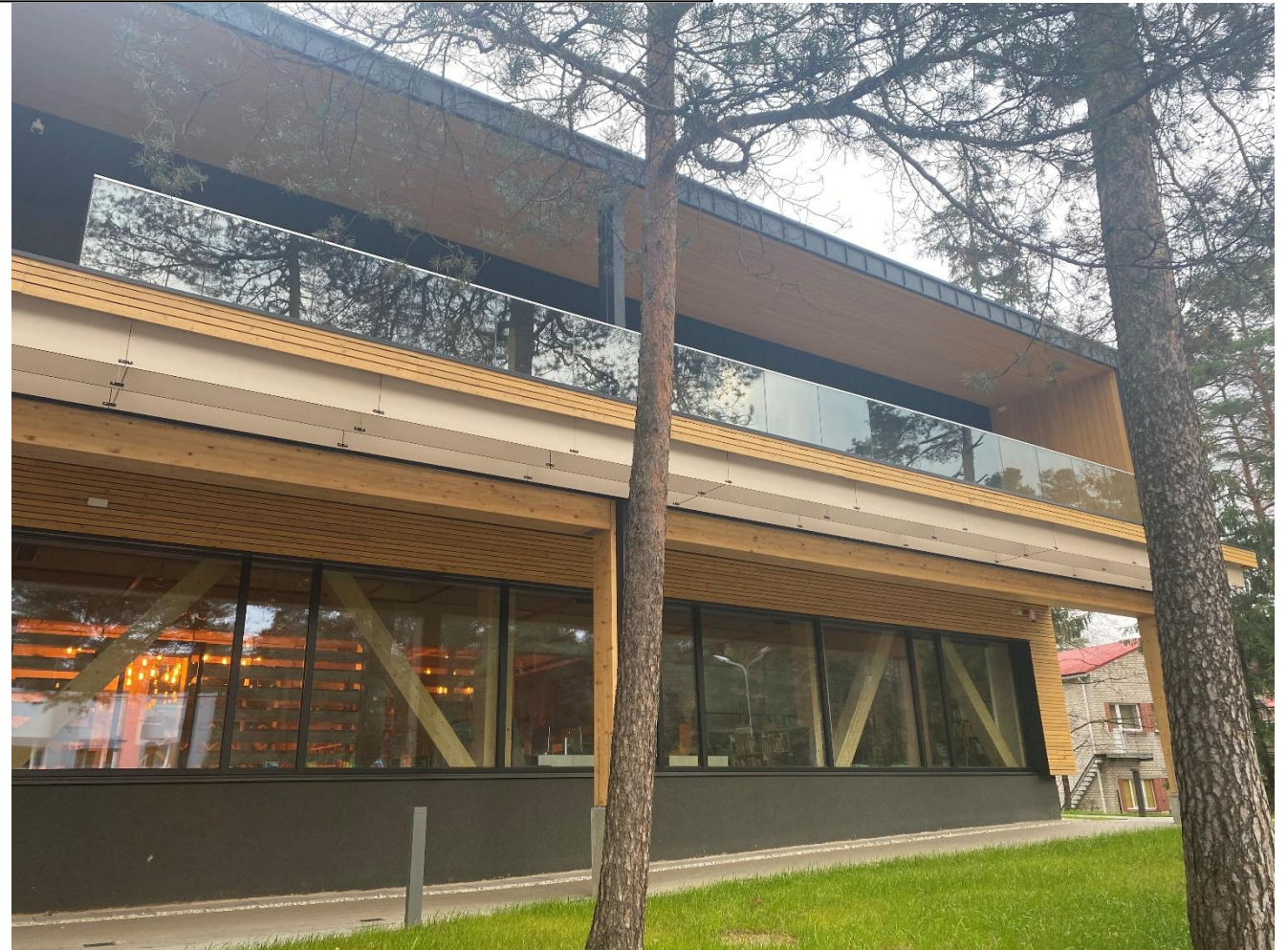
1. UN 2.STĀVA PĀRSEGUMU PĀRKĀRE DIENVIDU PUSĒ
