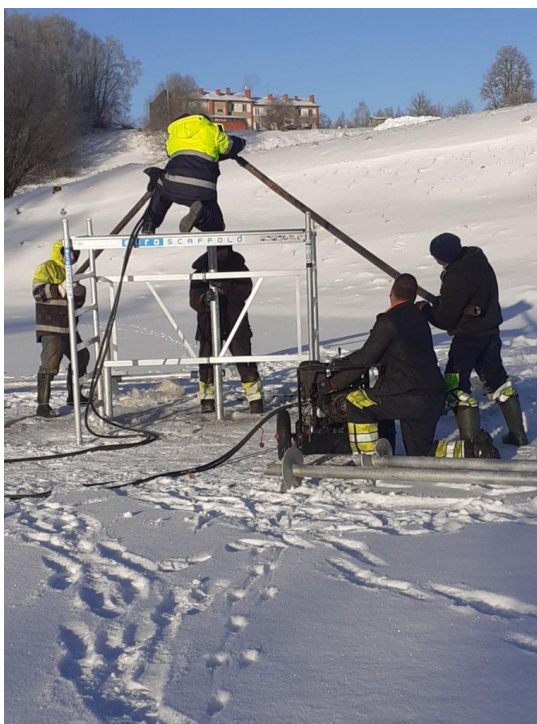
30. attēls. Laipas izbūve Dzērvies ezerā
