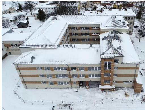
24. attēls. Pārskata gadā mainījās ģimnāzijas jaunāko klašu korpusa būvniecība
