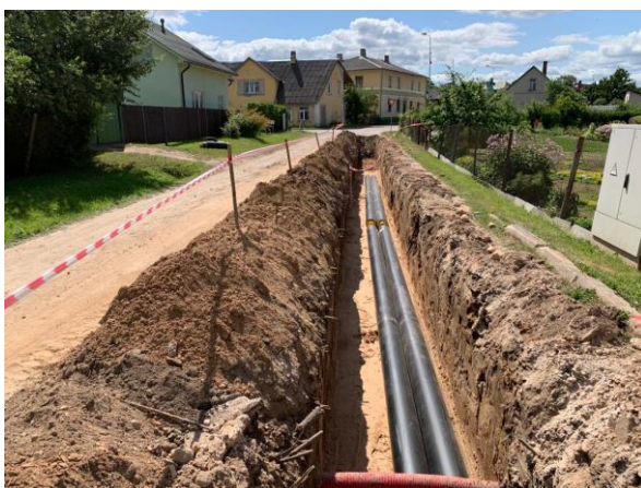
56. attēls. Būvniecības darbi objektā “Siltumtrases un siltummezglu izbūve Siguldas, Pumpura un Lāčplēša ielā, Alūksnē”
