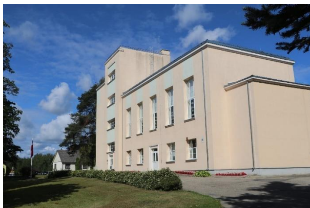
27. attēls. Ventilācijas ierīkošana Alūksnes pilsētas sākumskolas ēkā skolas iekštelpu gaisa kvalitātes uzlabošanai
