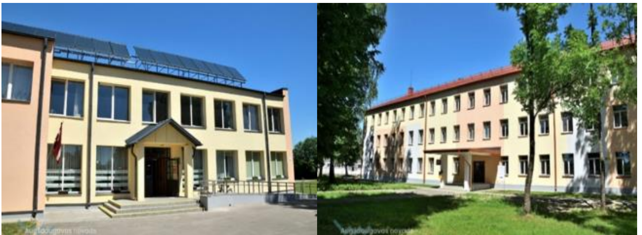
Objekts pieņemts ekspluatācijā
