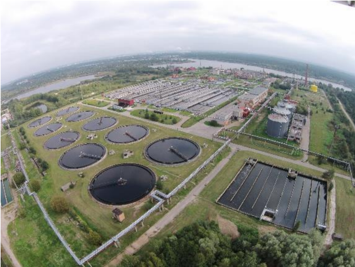
1.2. attēls. Daugavgrīvas bioloģiskās notekūdeņu attīrīšanas iekārtas (foto "Rīgas ūdens").
