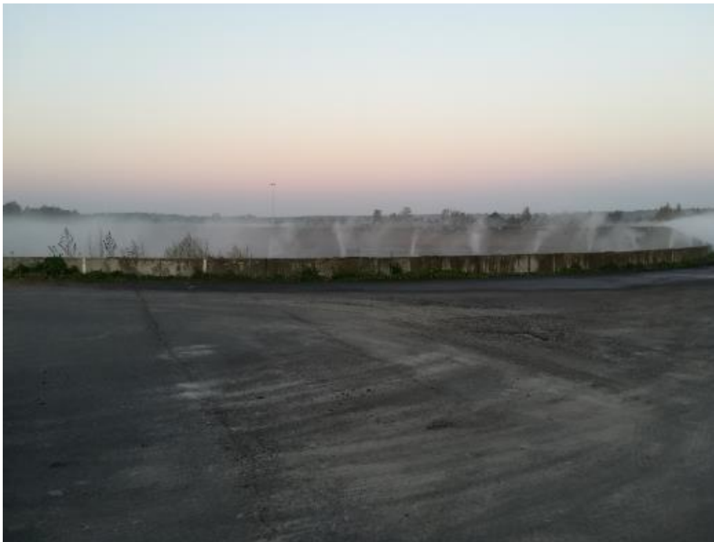
1.13. attēls. Dūņu lauki Vārnukrogā (foto: SIA “Rīgas ūdens”).
