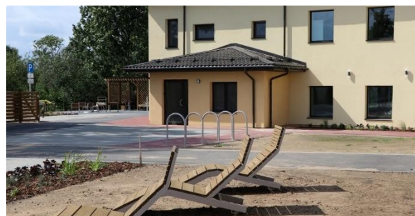
6.3.1.attēls. Dienas centra un grupu dzīvokļu izveide Aknīstē
