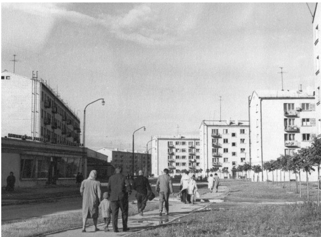
Attēls. 20.gadsimta sešdesmitajos gados no plašās Padomju Savienības Aizkrauklē ieradās celtnieki un sāka celt hidroelektrostaciju. 1961. gadā Aizkraukles pagasts tika nodēvēts par Pētera Stučkas pilsētciematu.
