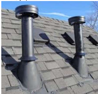
Ventilācijas izvads/ dūmenis ar šķērslī
