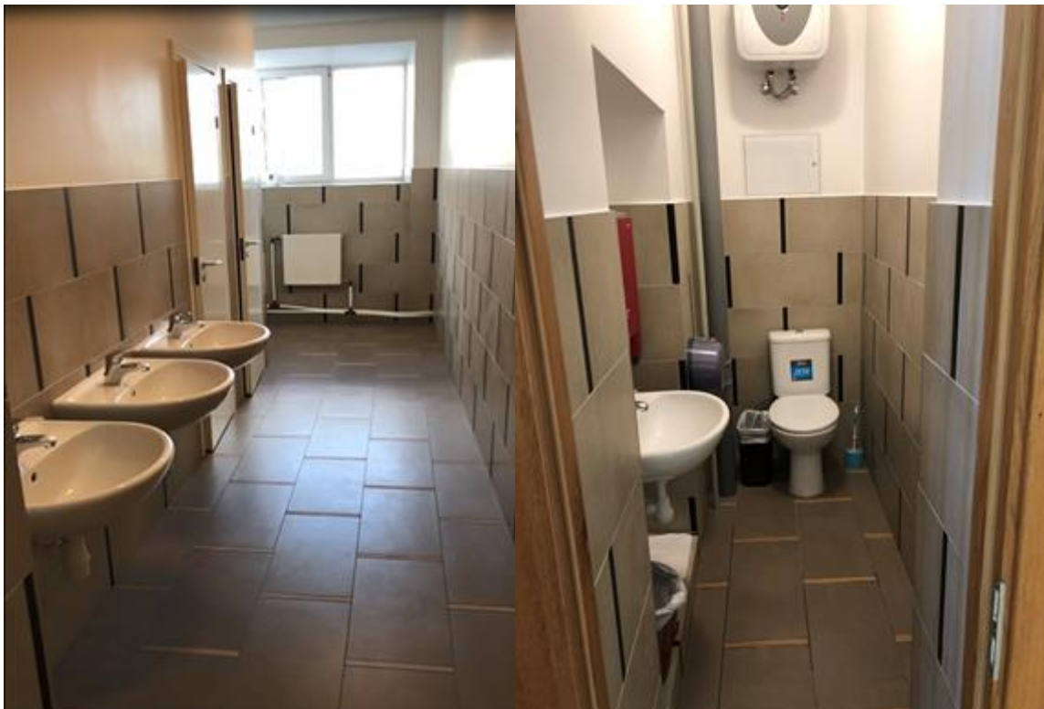
9. attēls. Pļaviņu novada ģimnāzijas 1. stāva zēnu un skolotāju tualetes pēc remonta
