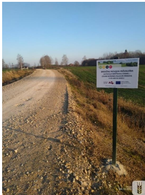
Projekta “Lauku grants ceļu pārbūve uzņēmējdarbības attīstībai Brocēnu novada Blīdenes un Gaiķu pagastos” ietvaros pārbūvētais autoceļš “Smiltnieku ferma - Līdumi”, Blīdenes pagastā
