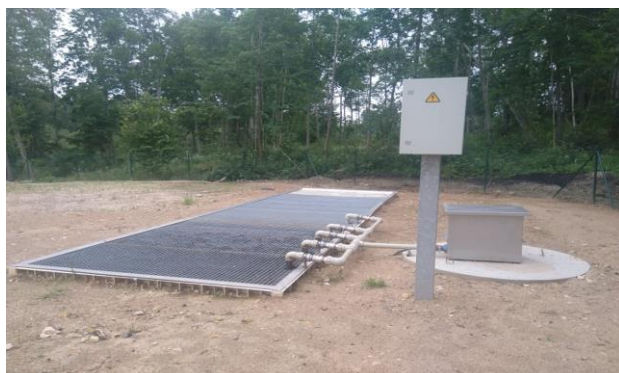
Projekta “Vides stāvokļa uzlabošana un potenciālā vides stāvokļa apdraudējuma riska novēršana, pārbūvējot notekūdeņu attīrīšanas sistēmu Gaiķu pagasta Satīķu ciemā” rezultāts
