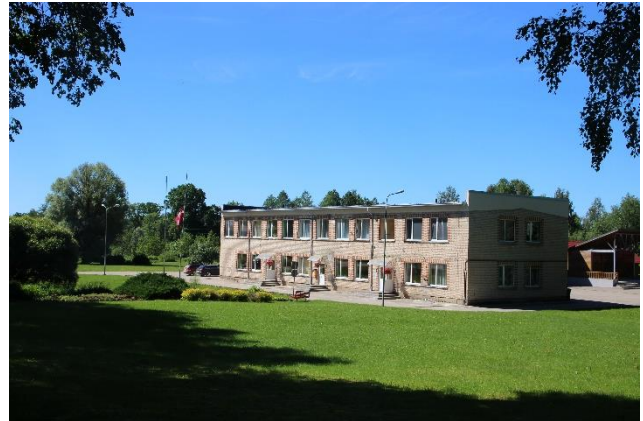
7. attēls. Elkšņu pagasta pārvaldes ēka
