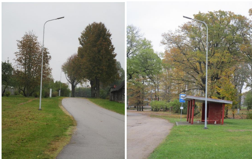
31.-32. attēli. Ierīkots ielu apgaismojums
