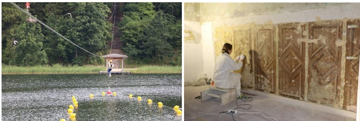
26.-27. attēli. Pārskata gadā noslēdzās gaisa trošu ceļa izbūve un turpinājās divu Alūksnes Jaunās pils telpu oriģinālās sienu un griestu apdares atsegšana
