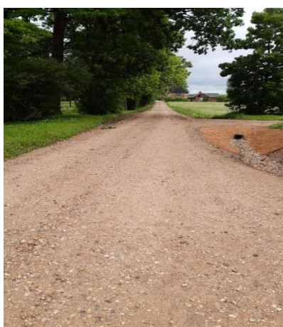
51. attēls. Autoceļu pārbūve Ziemera pagastā
