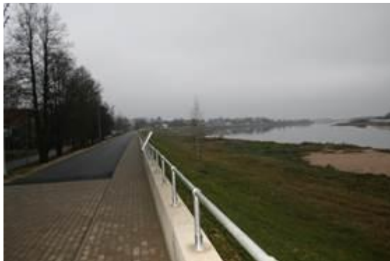
Fotogrāfija: no plūdu risku mazināšanas projekta Jēkabpilī
