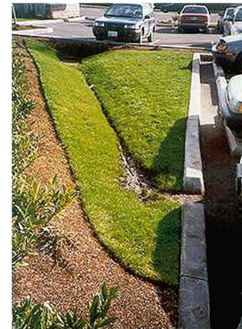
Fig. 53 b Overvann fra parkeringsplass dreneres til grøft som fordroyer og infiltrerer vann før det renner videre til overvannsledning. Seattle, USA Foto: Sveinn Thorolfsson, NTNU
