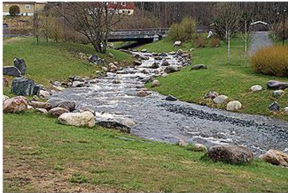
Fig. 15 Eksempel på åpning av en bekk som tidligere lå i rør. I tillegg er det etablert et nytt vannløp i et tidligere avløpsdraget, Trondheim. Foto: SINTEF Byggforsk
