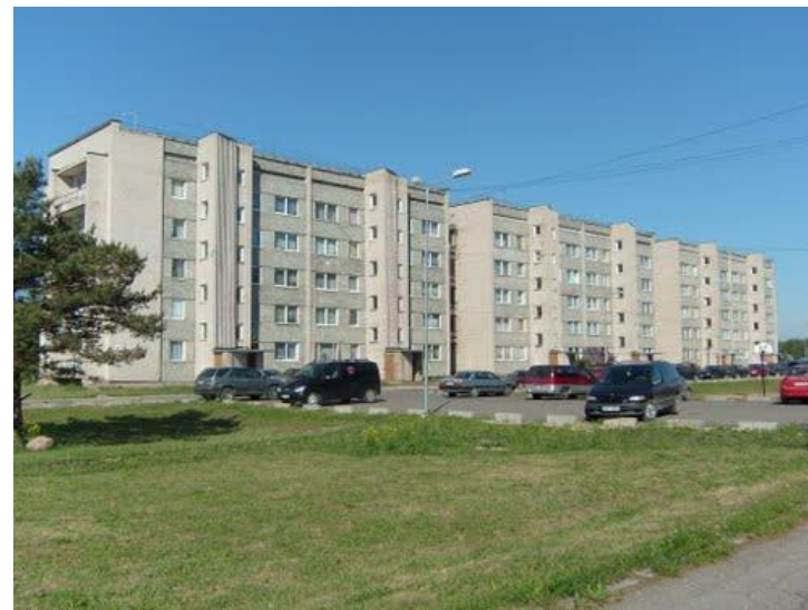
Jēkabpils, Neretas iela 35 un Neretas iela 37 (daļēja mājas renovācija/siltināšana)
